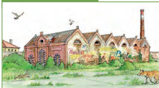
Usine 3 ans après sa fermeture
