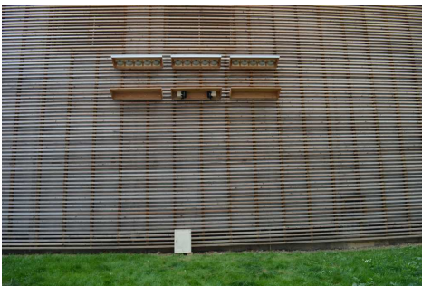
Photo : installation de batterie à hirondelles à Châlons-en-Champagne (Julia D'Orchymont)
